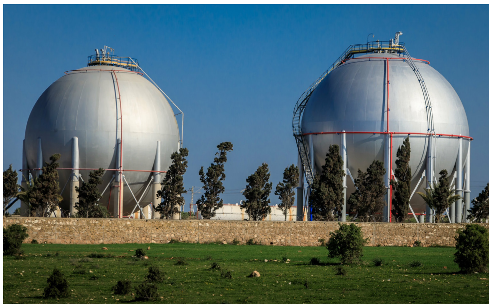
Figure 3: réservoirs sphériques typiques pour le stockage du gaz naturel (Source: Adobe Stock).
